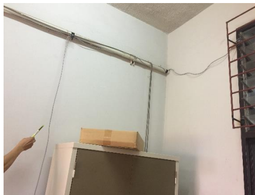
図 2. UNZA 内研究室に入線する UNZA ネットワークケーブル
